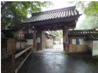
↓奈良県吉野町 吉水神社 義経主従、静が身を隠した。 「義経・静の間」がある。
